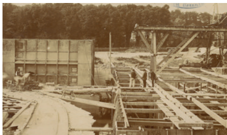
La construction des écluses de Saint-Aubin,
