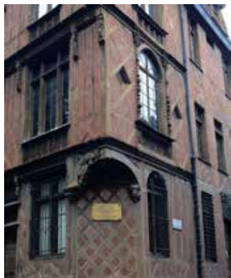
Bâtiment du 19 e siècle en pan-de-bois
